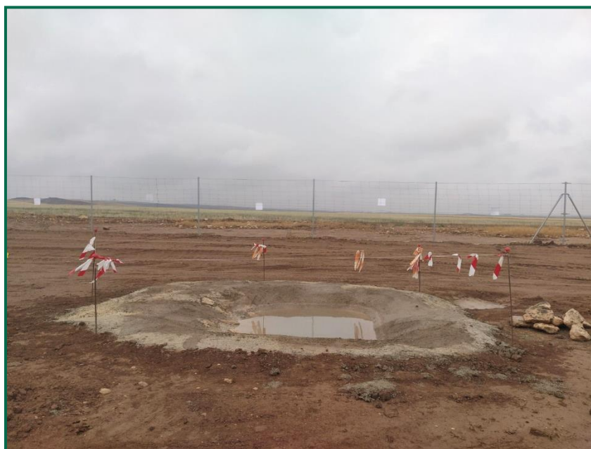
Fotografía 6. Balsa ya construido.
