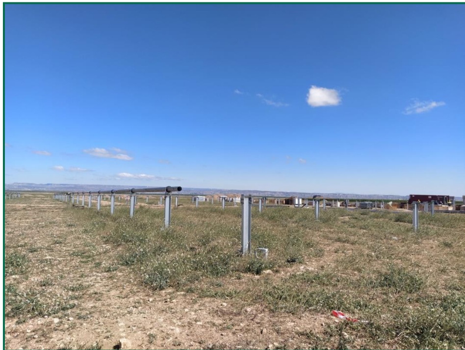
Fotografía 5. Hincas sobre el terreno.
