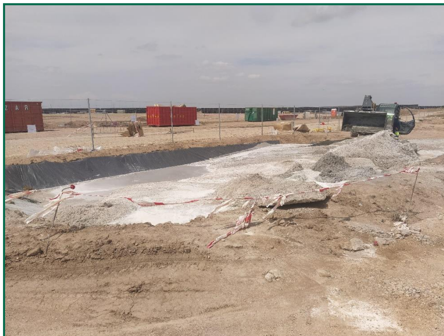
Fotografía 8. Zona de lavado de hormigón.
